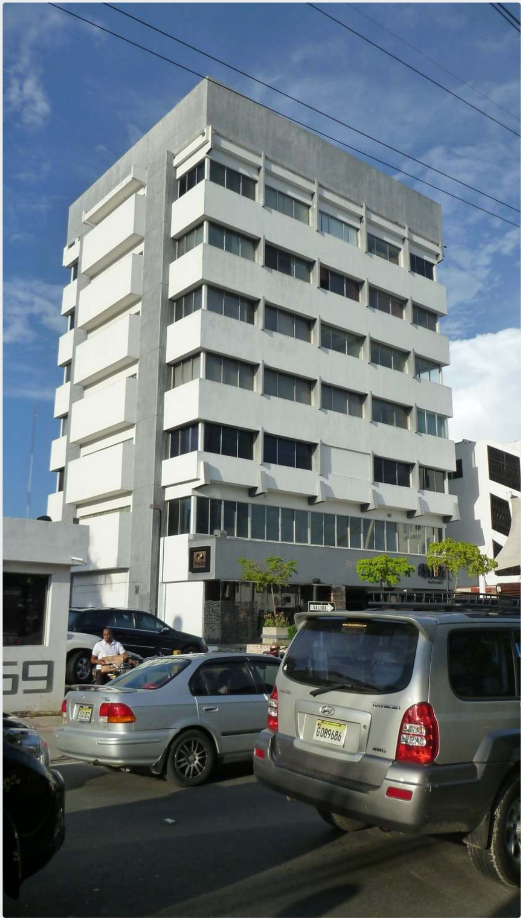
Vista desde la avenida. El muro perimetral con el número 69 es el único signo de identidad del inmueble.
