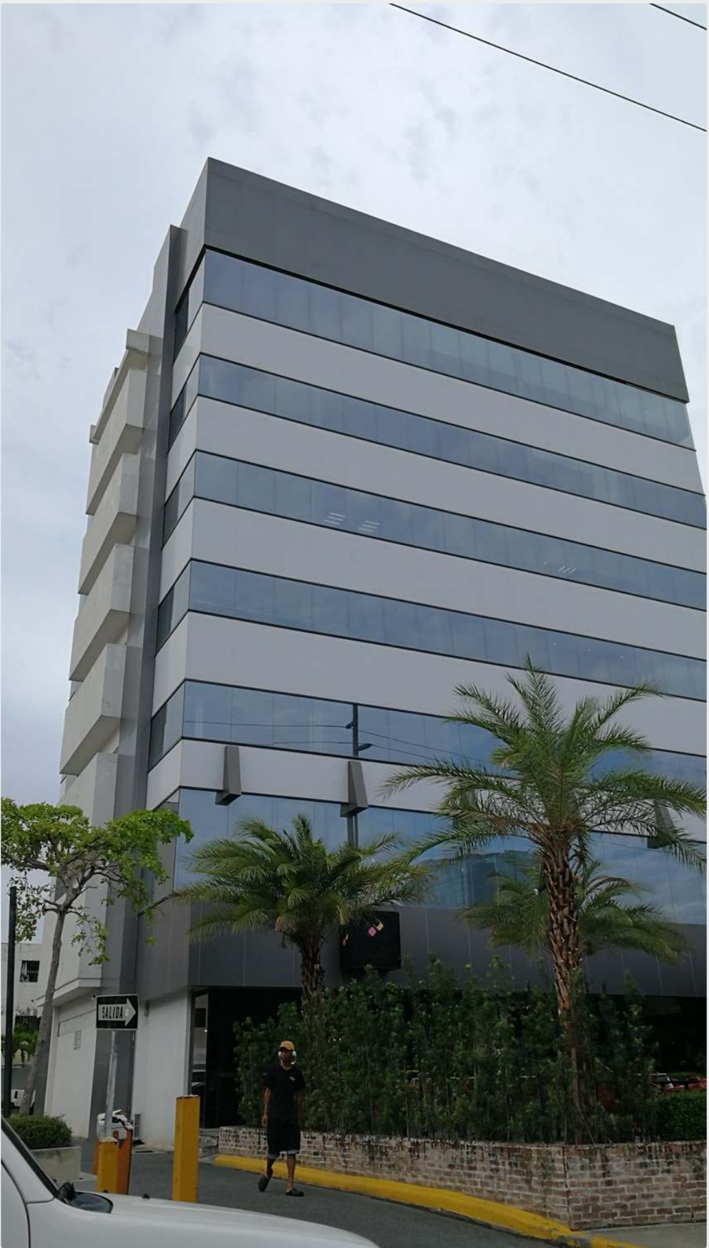
Vista de esquina. Bandas continuas, aletas grafito y coronación unificada. El volumen recupera proporción vertical.
