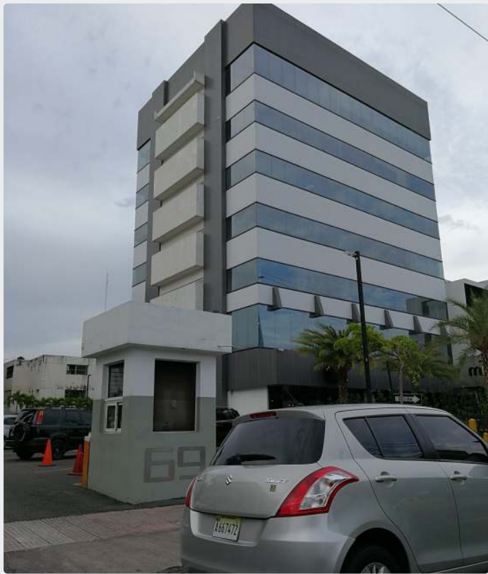
Acceso vehicular. La caseta de control ordena la entrada; el número 69 se conserva como signo de identidad.
