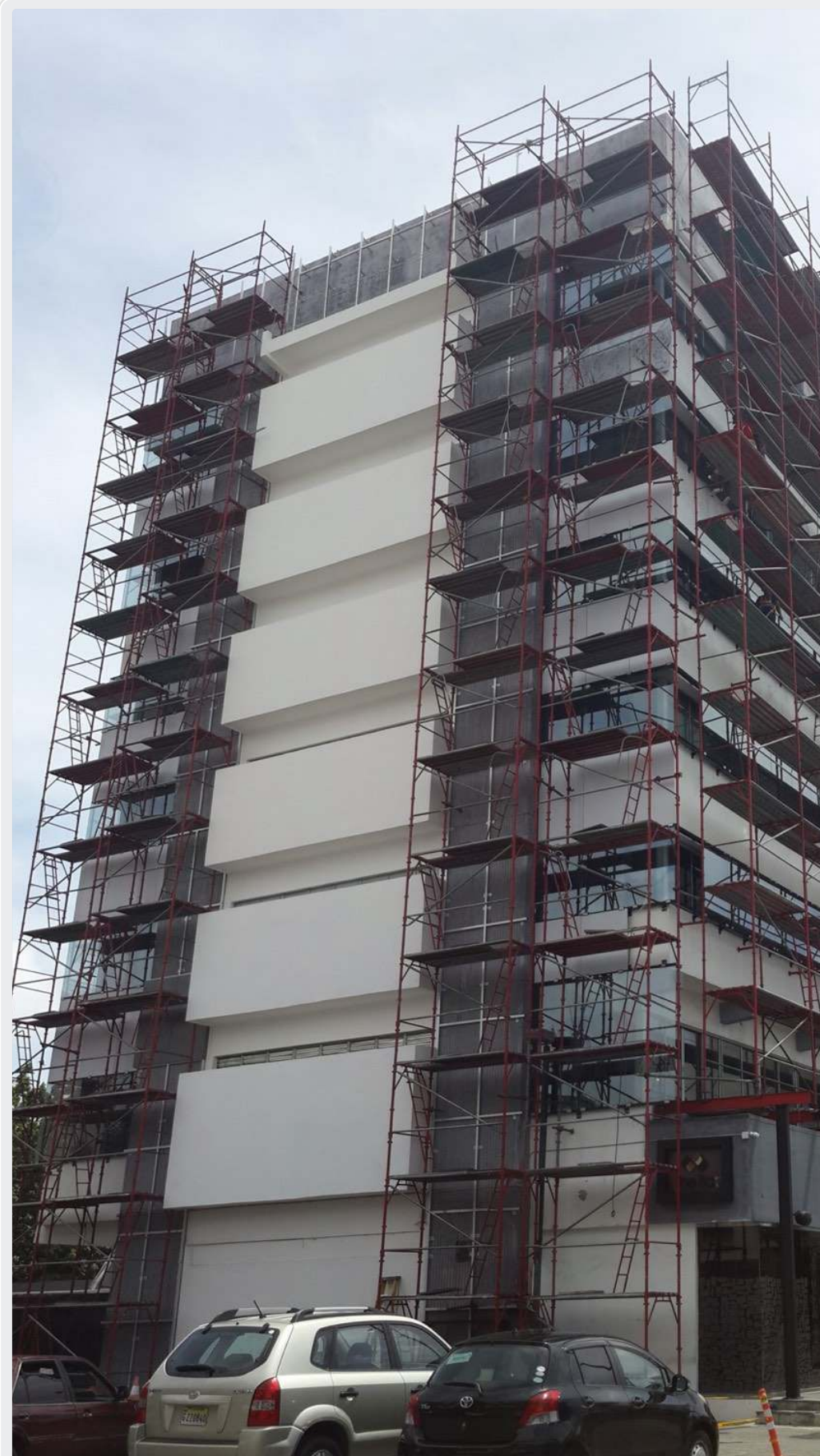
Agosto 2014. Andamiaje perimetral integral. El edificio se convierte en un solo frente de trabajo sin interrumpir su operación.
