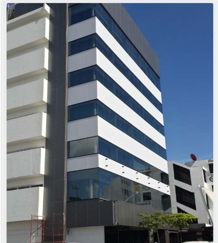
Diciembre 2014. La costura: revestimiento grafito ya colocado junto al lateral aún original. El antes y el después en una misma toma.
